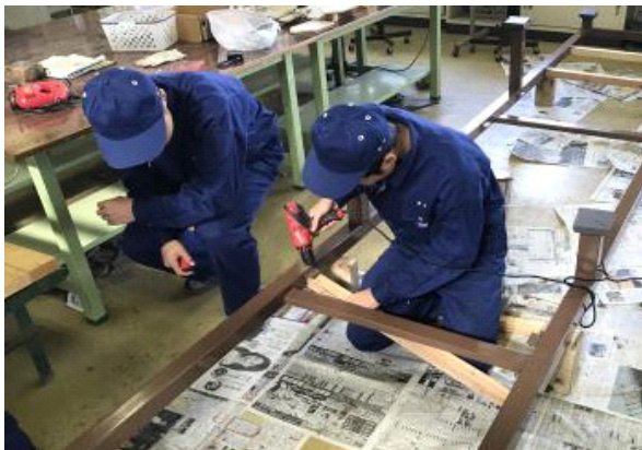
写真 56. スロープの枠の作成
