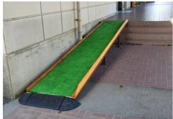
写真 57. 完成したスロープ
